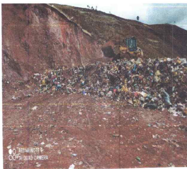
Imagen 16. Maquinaria pesada para el soterrado de los residuos sólidos en el área degradada del sector de Machuyoc.
